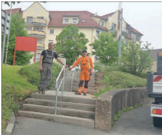
Mitarbeiter des Bauhofes der Stadt bei der Fertigstellung
